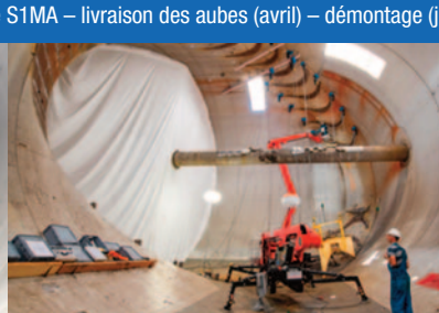
Chantier coude 1 de S1MA – livraison des aubes (avril) – démontage (juillet-août) – remontage (octobre 2024).
