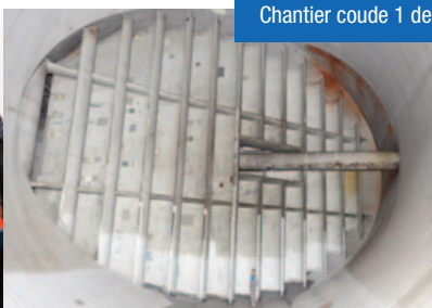
Chantier coude 1 de S1MA – livraison des aubes (avril) – démontage (juillet-août) – remontage (octobre 2024).
